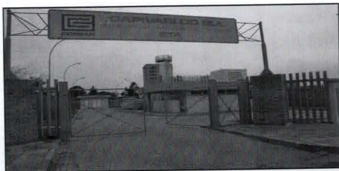
Figura: 11 A -Nova Estação de Tratamento de Água (ETA) de Capivari do Sul, Inaugurada em 2017.
